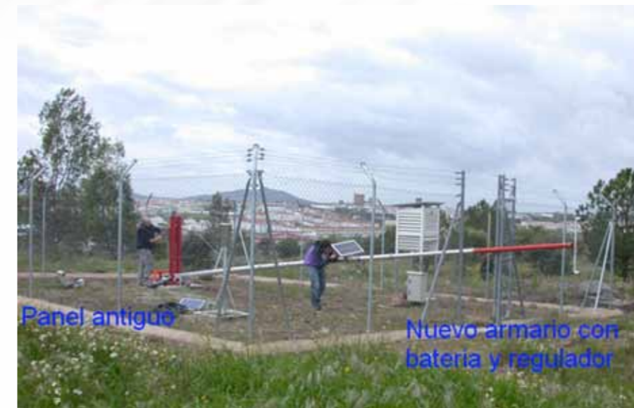
Estación de Olivenza. Cambiando panel de la torre abatida
